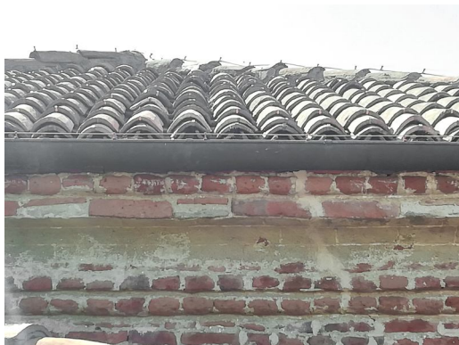
Esempio di posa dei cavetti su linea di gronda e colmi
