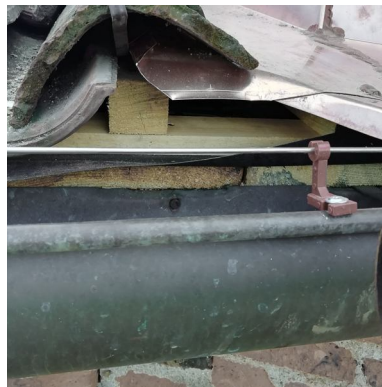
Esempio di posa dei cavetti su linea di gronda e colmi
