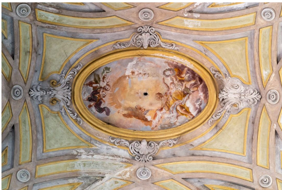
Foto n. 7 affresco dell'ovale della cupola con macchie ed efflorescenze saline
