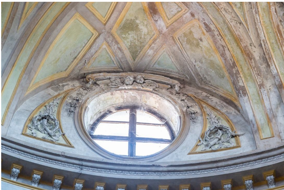
Foto n. 3 efflorescenze saline macchie e perdita di pellicola pittorica – lato nord
