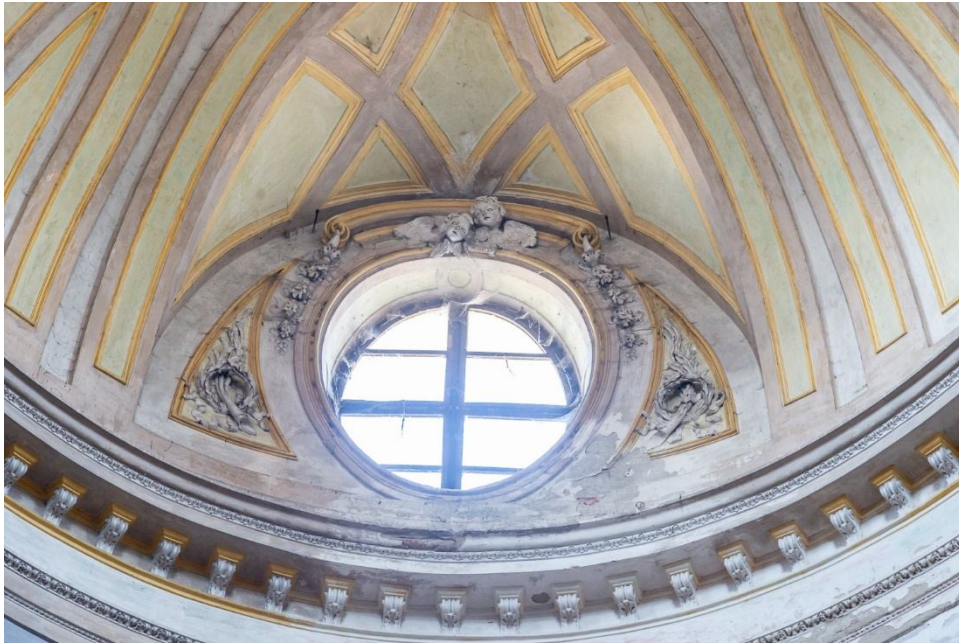
Foto n.4 – finestra lato ovest con perdita di finitura nella parte inferiore
