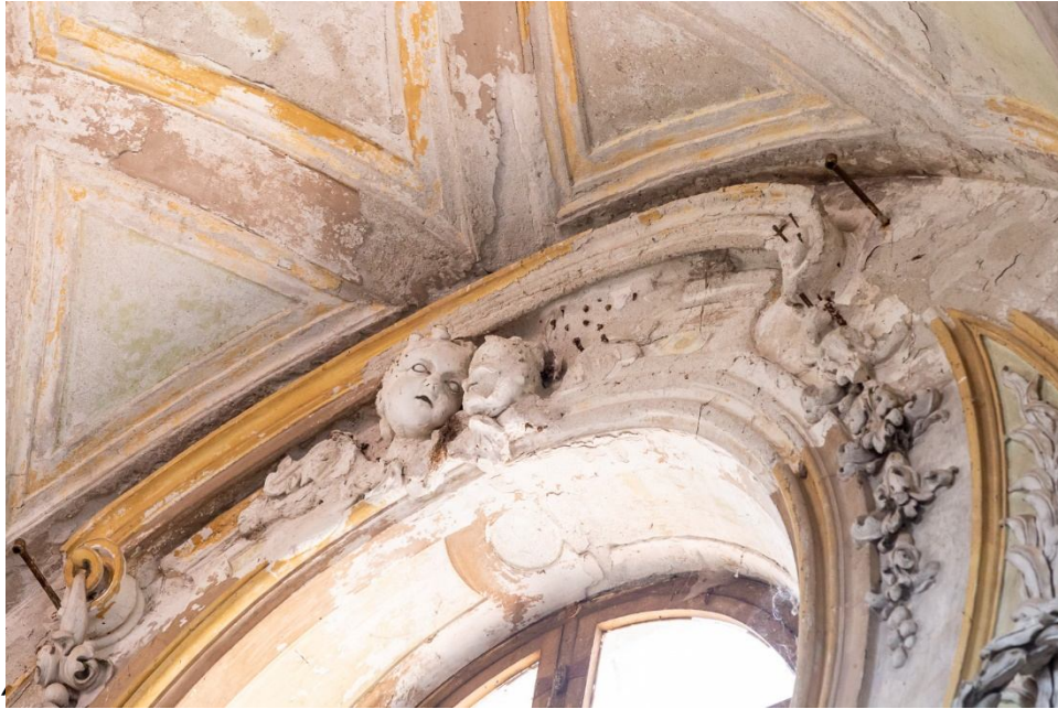
Foto n. 6 – particolare di cornice finestra lato sud con lacune e mancanze
