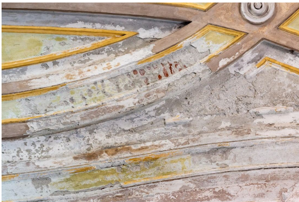
Foto n. 1 – particolare lato est con distacco di materiale sino alla tessitura muraria
