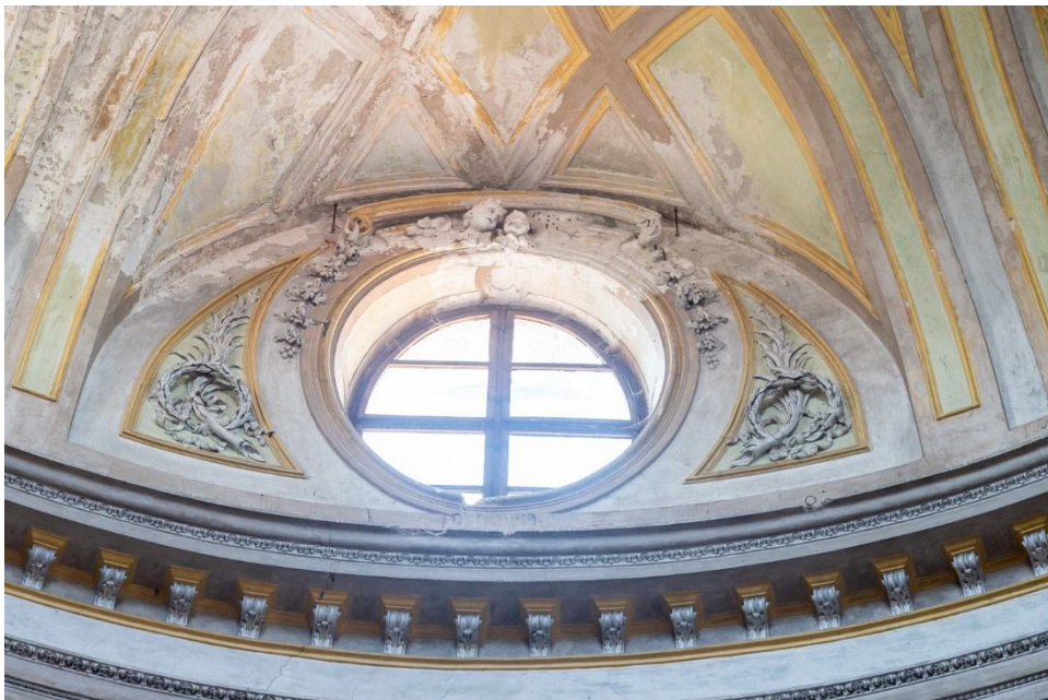
Foto n. 5 – finestra lato sud
