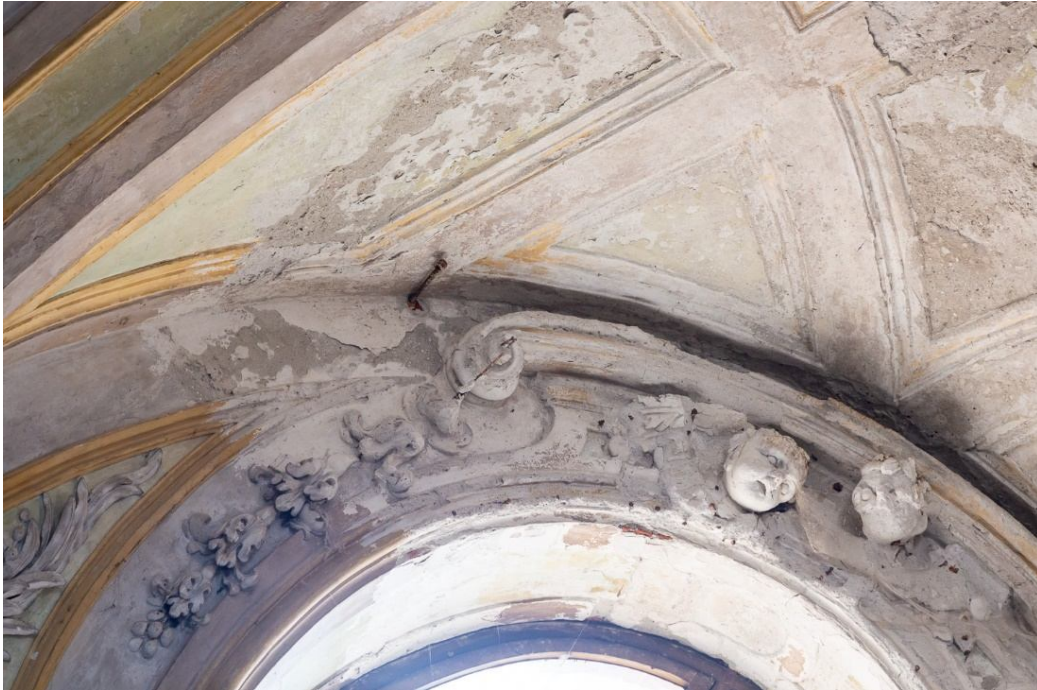
Foto n. 2 – particolare di cornice degradata in stucco della finestra - lato nord
