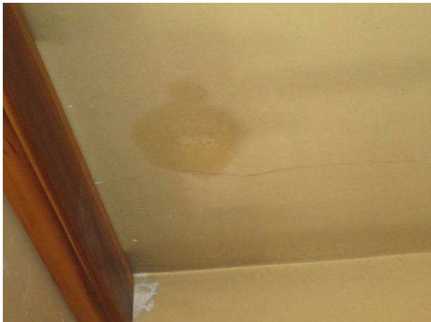
Foto 47 infiltrazione
