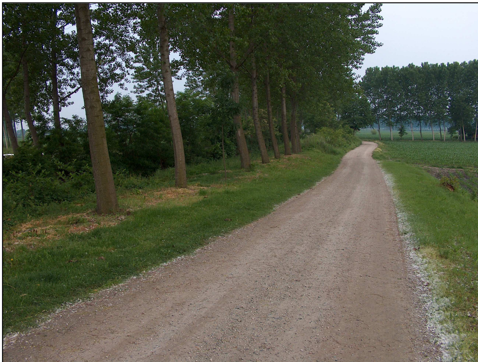
Figura 3 - Cavour, tratto di strada campestre da riqualificare
