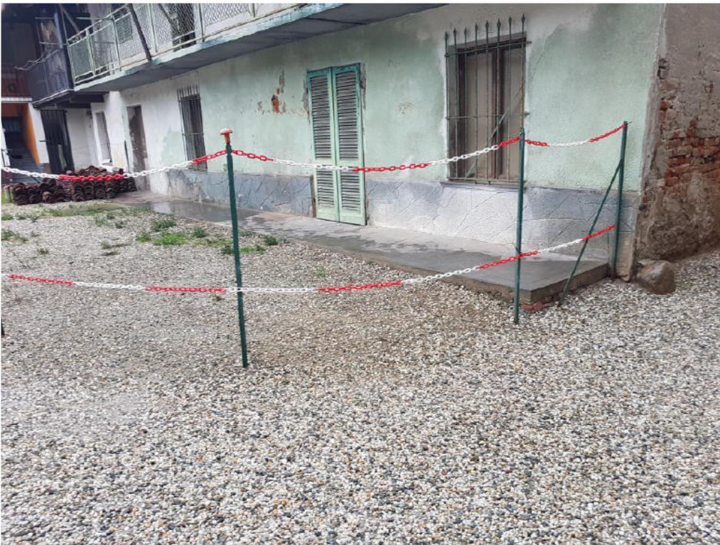
Vista interno cortile
