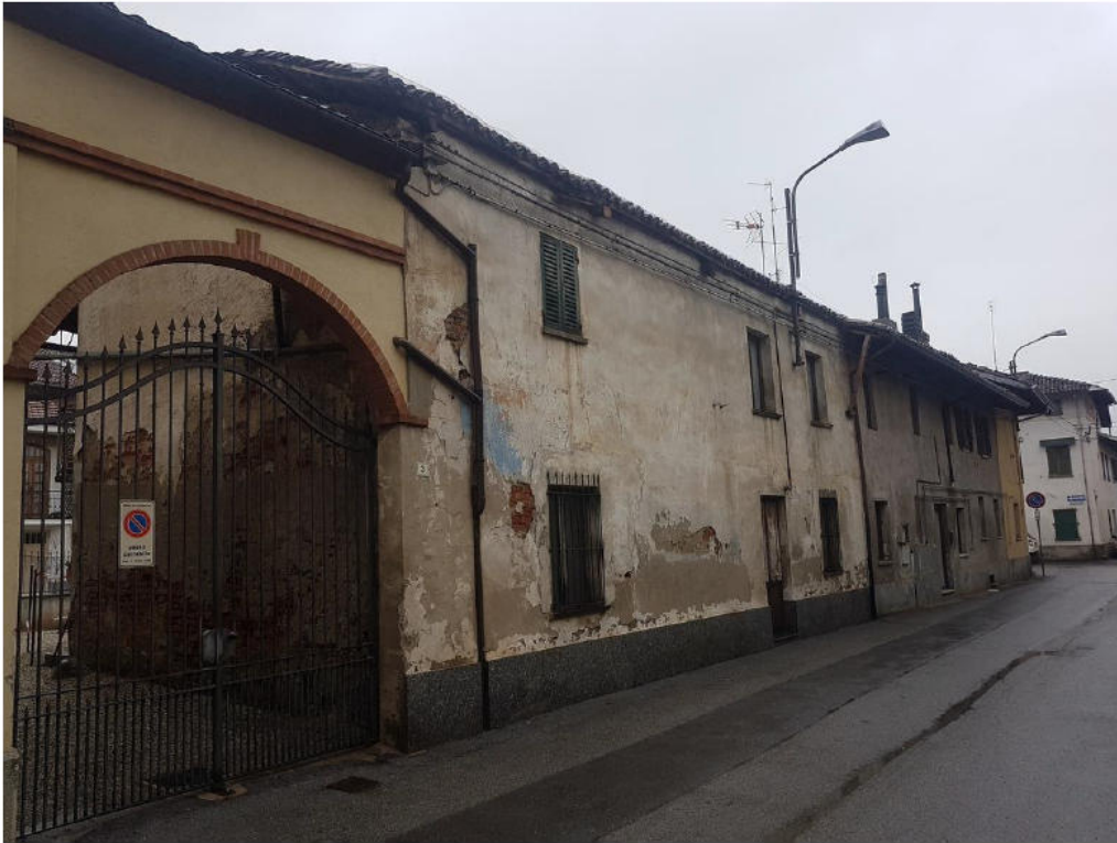
Vista fronte strada
