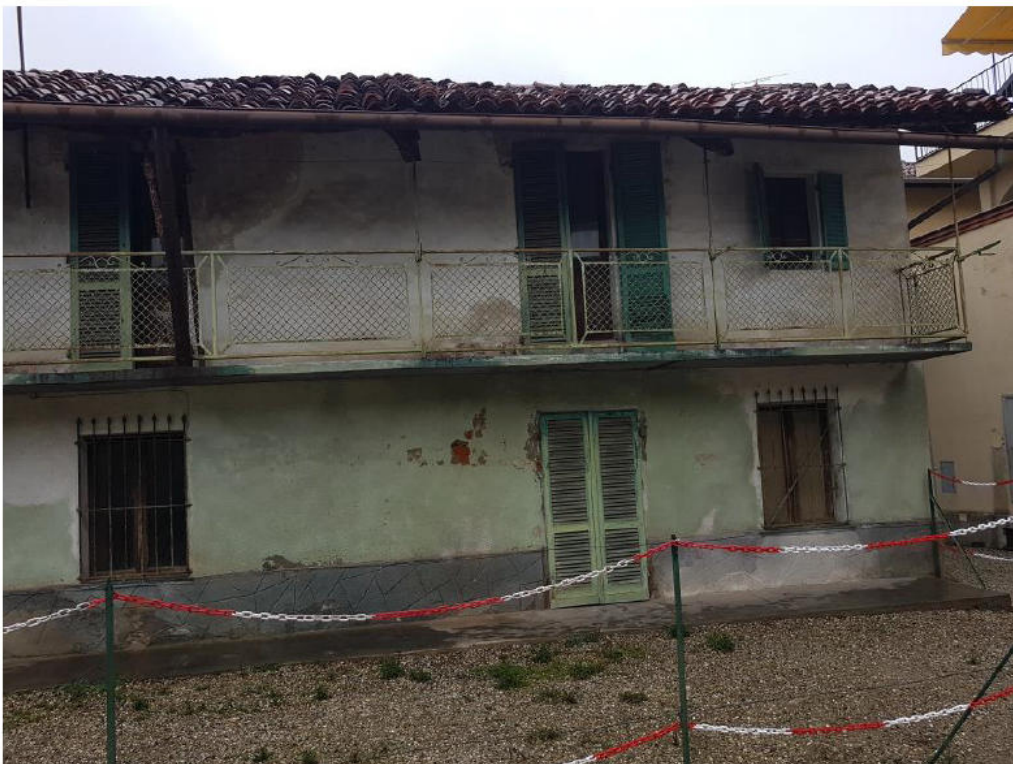
Vista interno cortile
