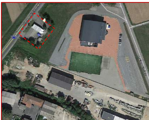
Vista aerea con individuazione dell'area di intervento (DC1)
