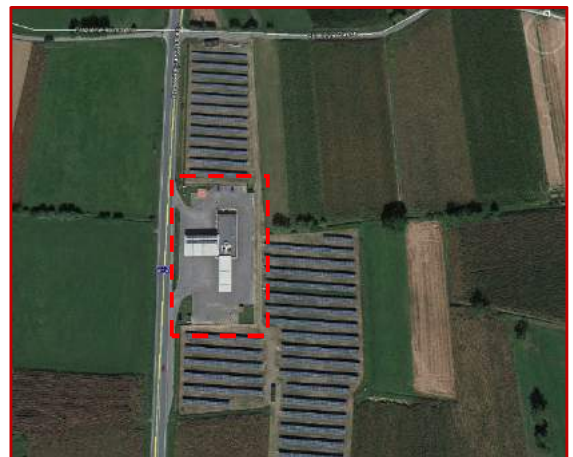
Vista aerea con individuazione dell'area di intervento (DC2)
