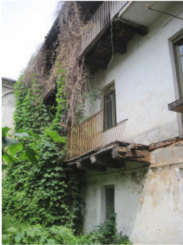
Vista del fabbricato dal cortile interno (fabbricato 13:08:05)
