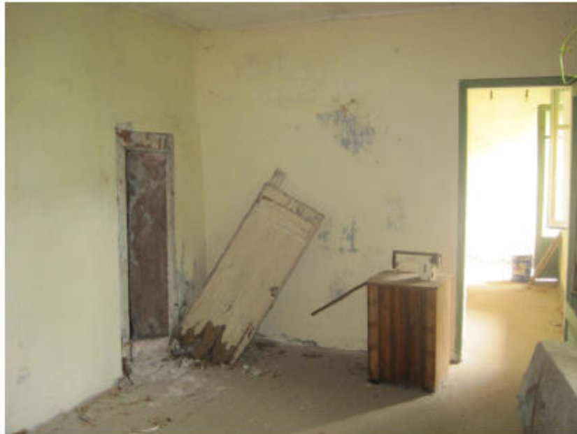
Vista interna del fabbricato (fabbricato 13:08:05)
