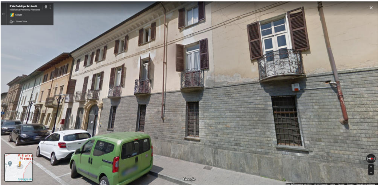
Vista da via Martiri della Libertà (fabbricato 13:08:01)
