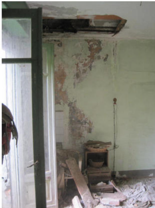
Vista interna del fabbricato (fabbricato 13:08:05)
