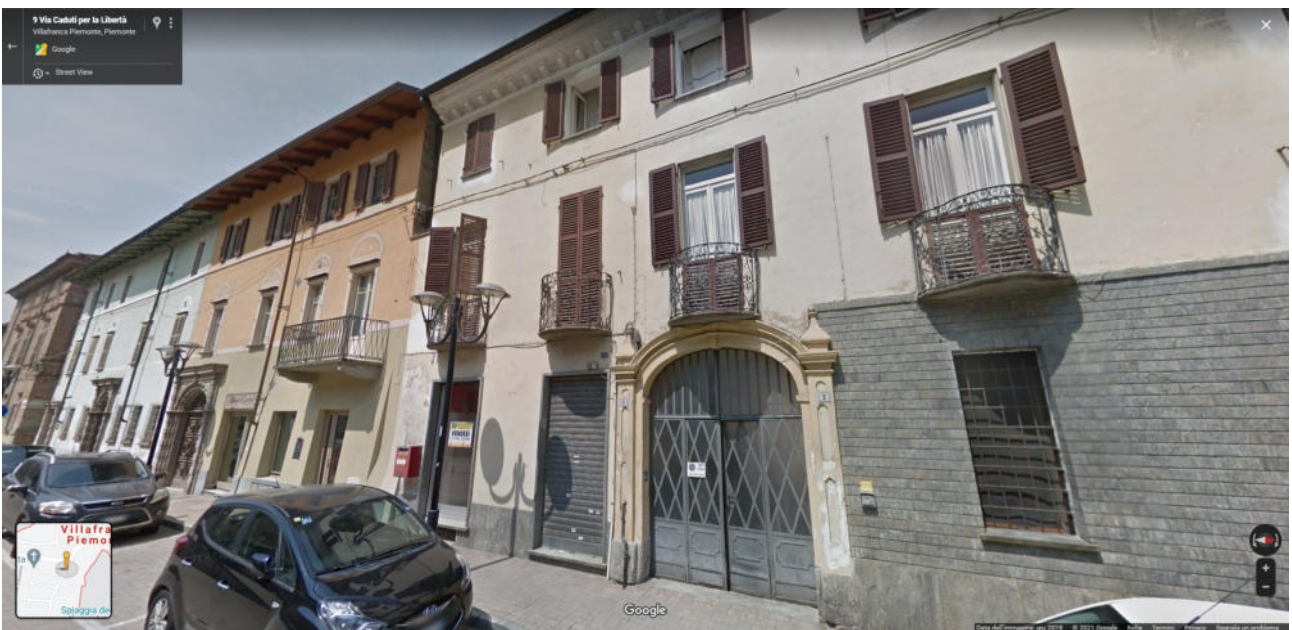
Vista da via Martiri della Libertà (fabbricato 13:08:01)
