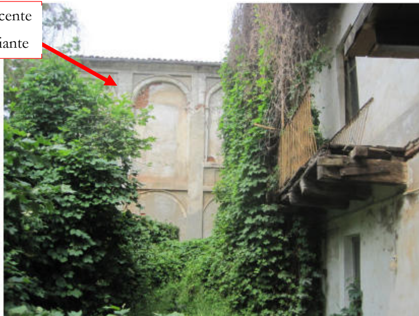
Vista del fabbricato dal cortile interno (fabbricato 13:08:05)
